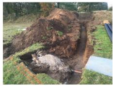
La canalisation de vidange du filtre à sable était totalement obstruée par des résidus de Neutralite : lors d'une tentative de débouchage, nous avons constaté qu'elle était très hétéroclite (PVC, béton,...), cassée en plusieurs endroits et étrangement imbriquée dans les canalisations d'entrée et sortie du réseau de distribution. Il a donc été
